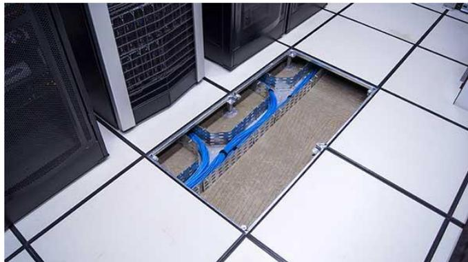
Figura 1- Cabeamento sobre piso elevado
