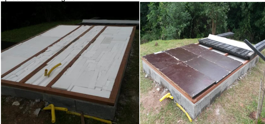
Figura 4 – Assoalho de compensado naval e isolamento de isopor.
