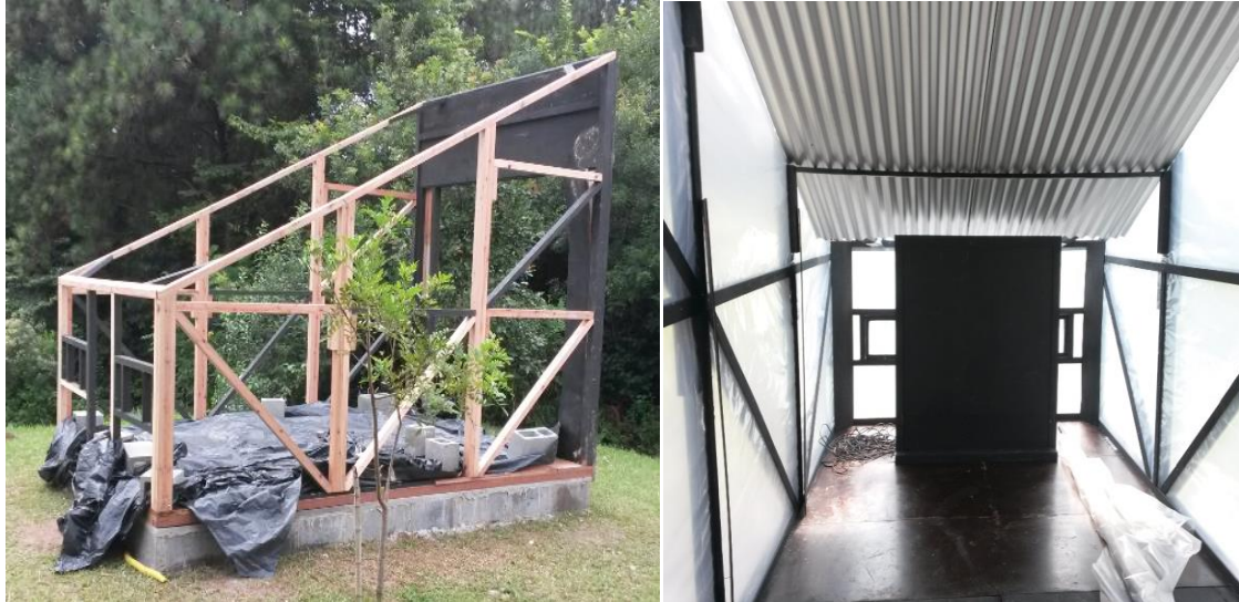
Figura 5 – Estrutura de madeira, visão interna da estufa.
