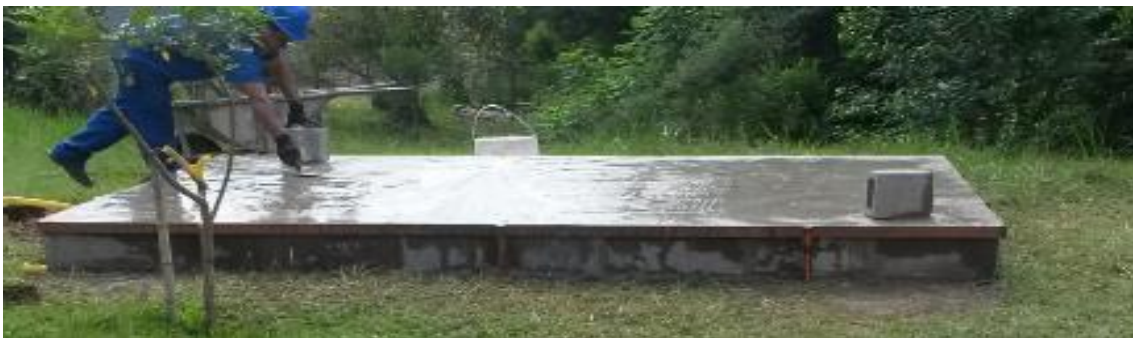
Figura 3 – Quadro de blocos de concreto para fundação e preenchimento com pedras britas.
